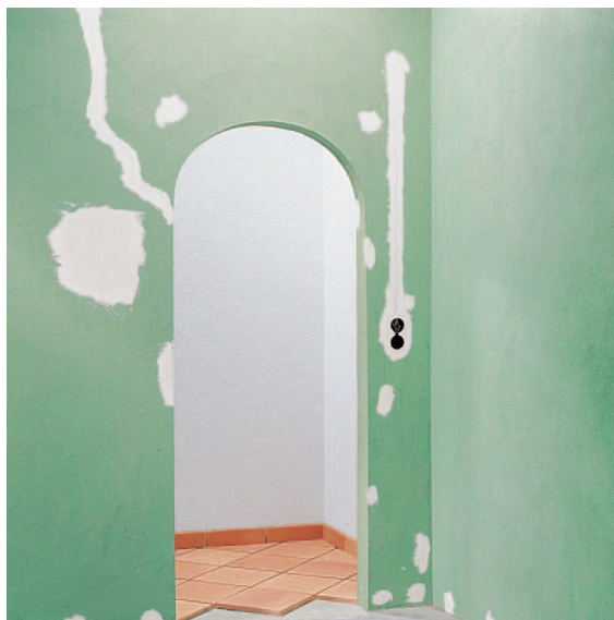
Заделка трещин при помощи GLATTE SACHE.
