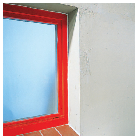
Уплотнение стыковочного шва между окном и кирпичной кладкой.
