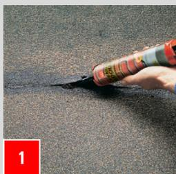
**Ремонт крыши:** выдавить герметик под рубероид.
