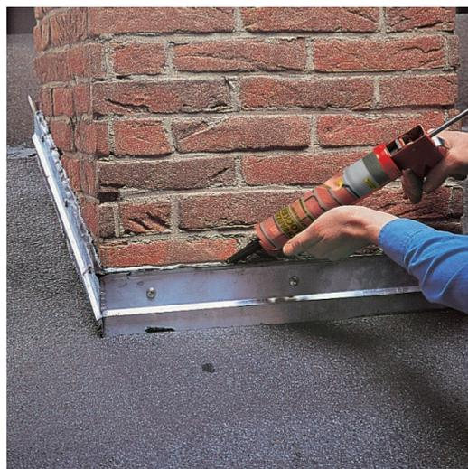
Гидроизоляция шва между кирпичной кладкой и цинковой полосой на дымоходной трубе с помощью LUGATO SCHWARZER BLOCKER DICHTMASSE.
