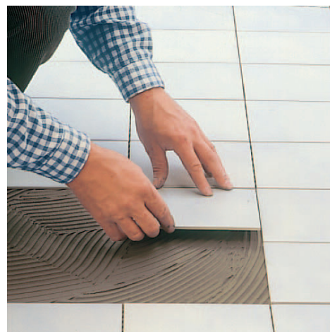
Укладка плитки на подогреваемый бесшовный пол.
