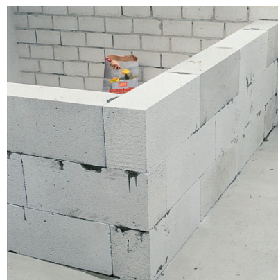
Стена уложена при помощи клея LUGATO SICHERHEITSKLEBER PORENBETON.
