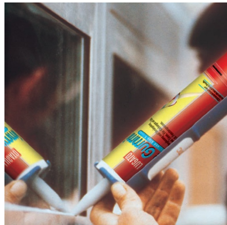
Заделка шва на оконной раме между стеклом и алюминием.
